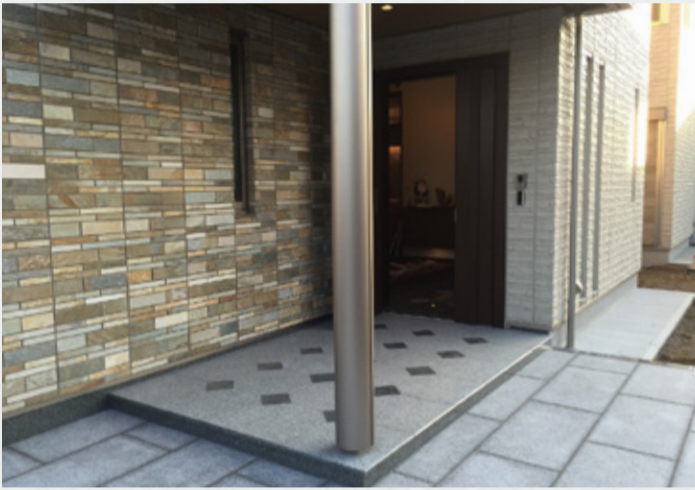
玄関石張貼り
